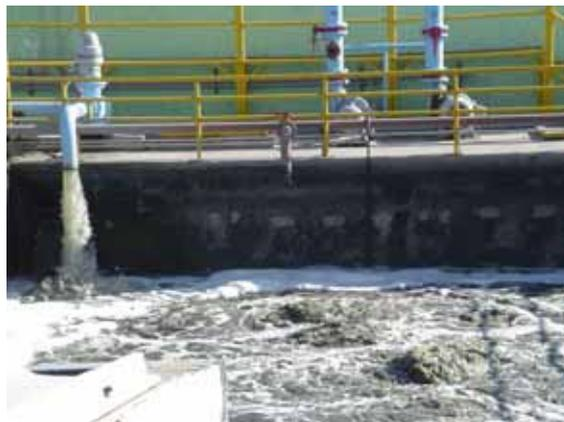
**Figura 3. Primer reactor secuencial de reacción en una PTAR ciudad de Torreón,**
