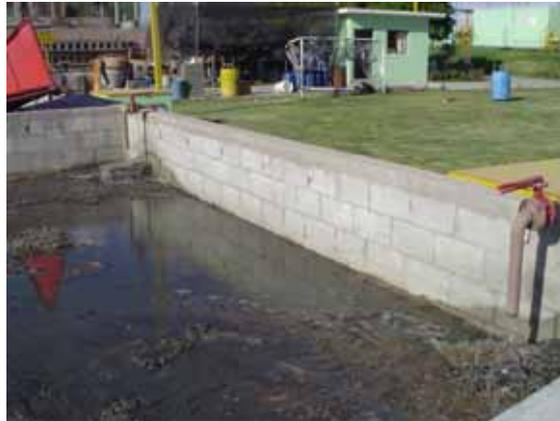
**Figura 5. Descarga de lodos en el lecho de secado en una planta tratadora de aguas.**
