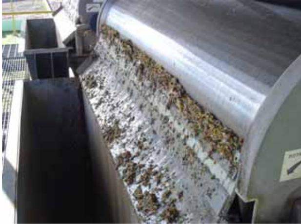
**Figura 1. Área de pretratamiento con criba rotatoria para la separación de semillas en una planta tratadora de aguas residuales (PTAR) en la ciudad de Torreón, Coahuila.**
