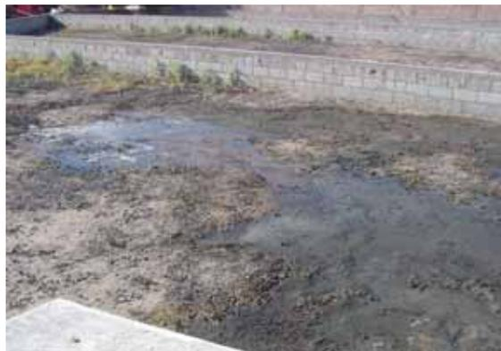
**Figura 6. Lodos en el lecho de secado a cielo abierto en la planta tratadora de aguas residuales de Torreón, Coahuila.**
